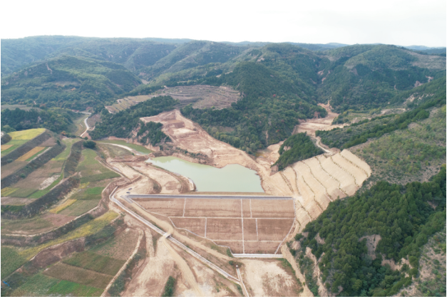
图15 延安市安塞区南沟淤地坝除险加固工程
