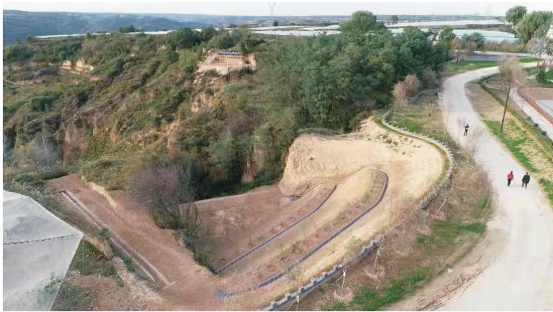
图20 延安市洛川县塬面保护工程
