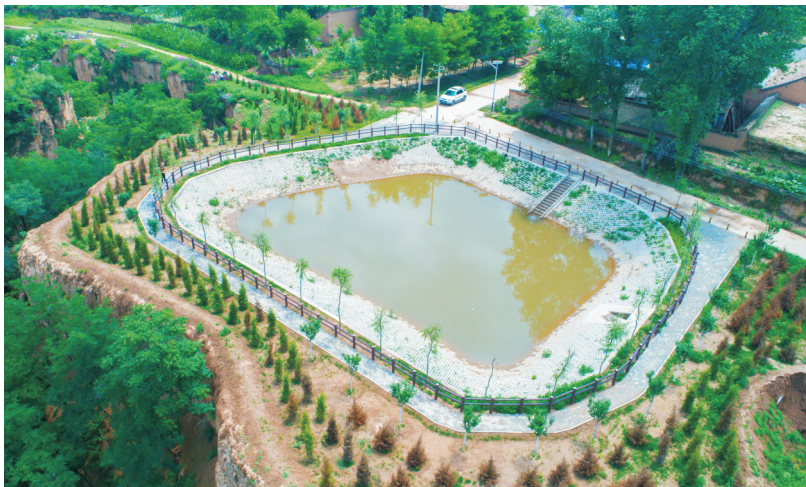
图21 咸阳市旬邑县塬面保护工程
