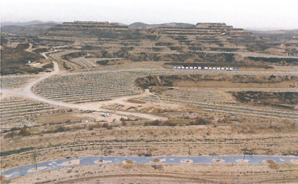
图18 榆林市米脂县马家沟坡耕地综合治理工程
