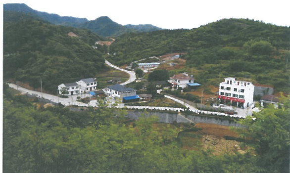
图27 石泉县杨柳生态清洁小流域示范工程
