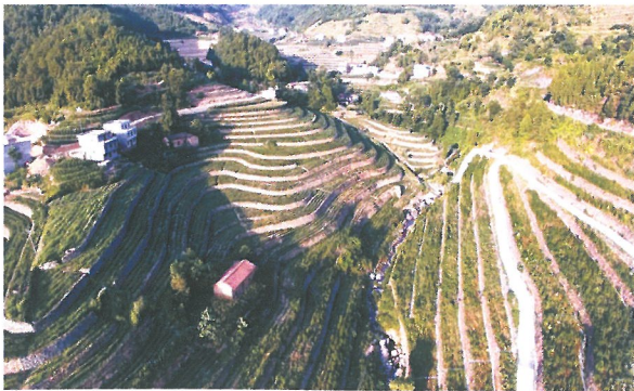
图19 安康市汉滨区牛蹄坡耕地综合治理工程
