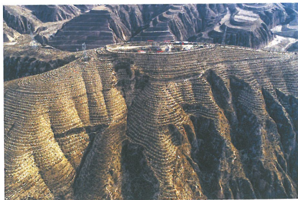
图14 榆林市绥德县小流域鱼鳞坑整地造林工程
