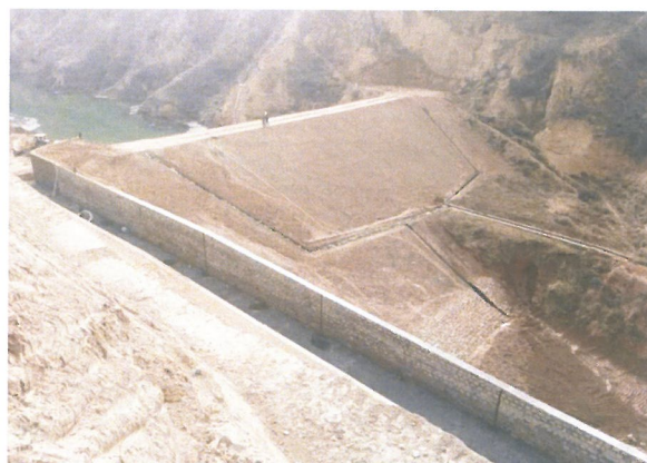
图17 志丹县淤地坝除险加固工程
