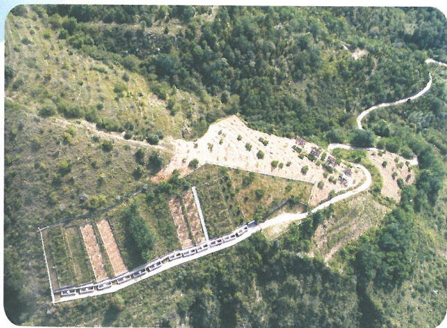
图42 延安市宝塔区王皮湾小流域综合观测站
