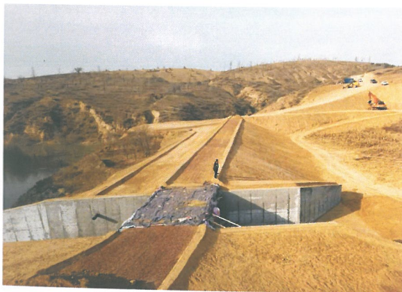
图16 神木市淤地坝除险加固工程
