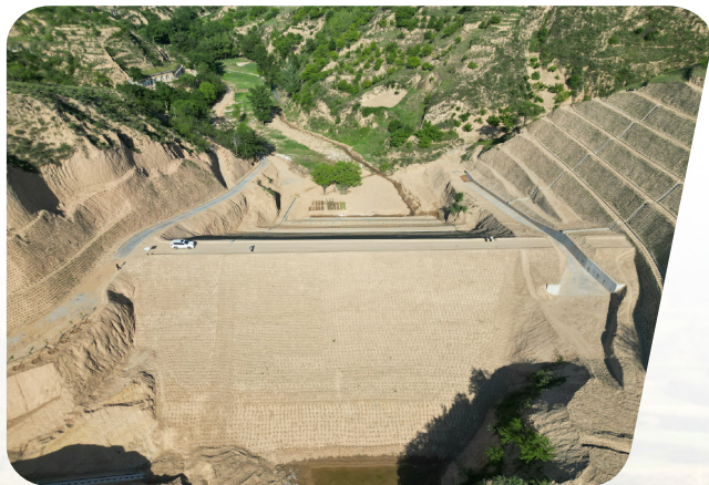
米脂县老树沟中型拦沙坝
