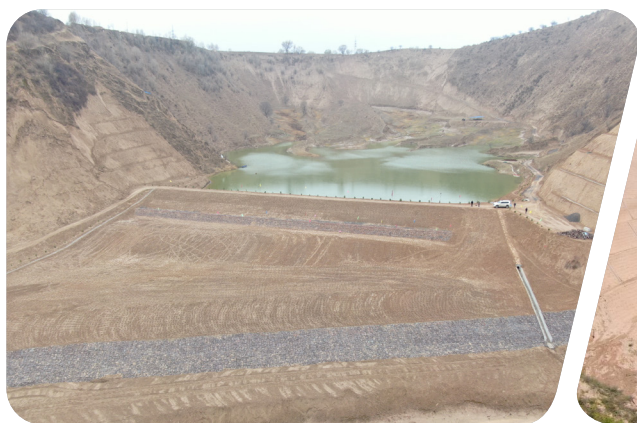
吴起县大星渠村小型淤地坝
