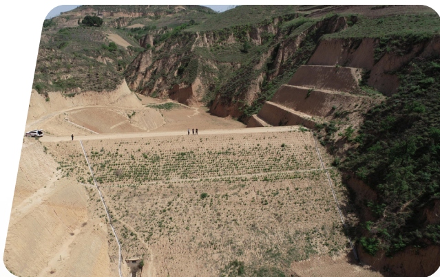
清涧县小角沟小型拦沙坝
