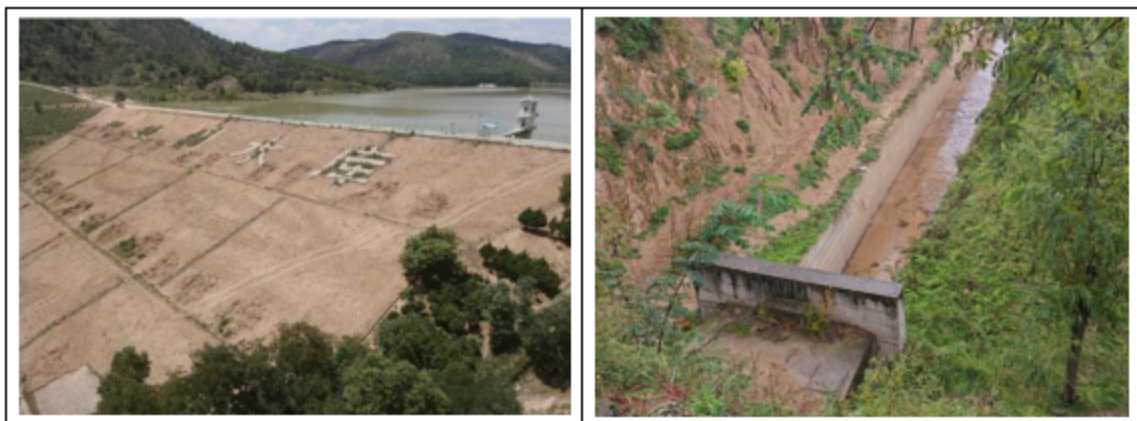
图 3.8.2-1 中山川水库大坝现状及生态流量泄放渠
