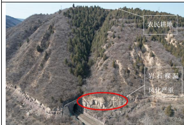
K120+119~+180 马家沟隧道进口风化剥落
